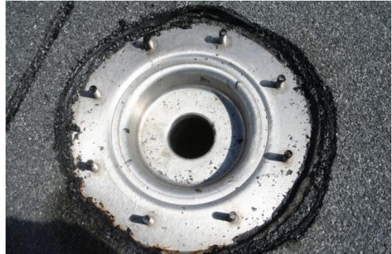
*Рисунок Ж.3 – Водоизоляционный ковёр не наклеен на фланец воронки внутреннего водостока*
