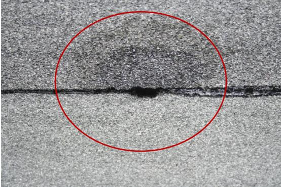
*Рисунок Ж.2 – Тёмное пятно (пережог) на поверхности наплавляемого рулонного материала*
